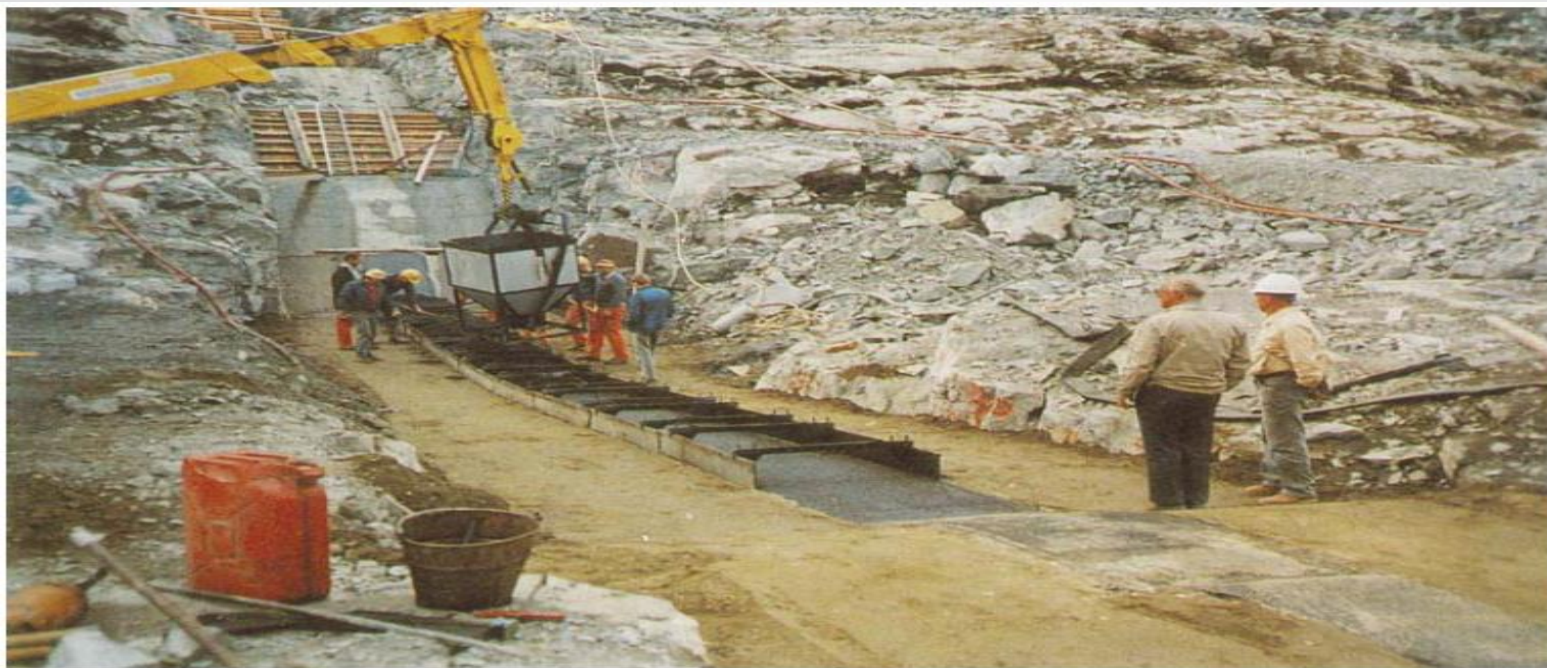
شکل ۶- پخش دستی بتن آسفالتی
