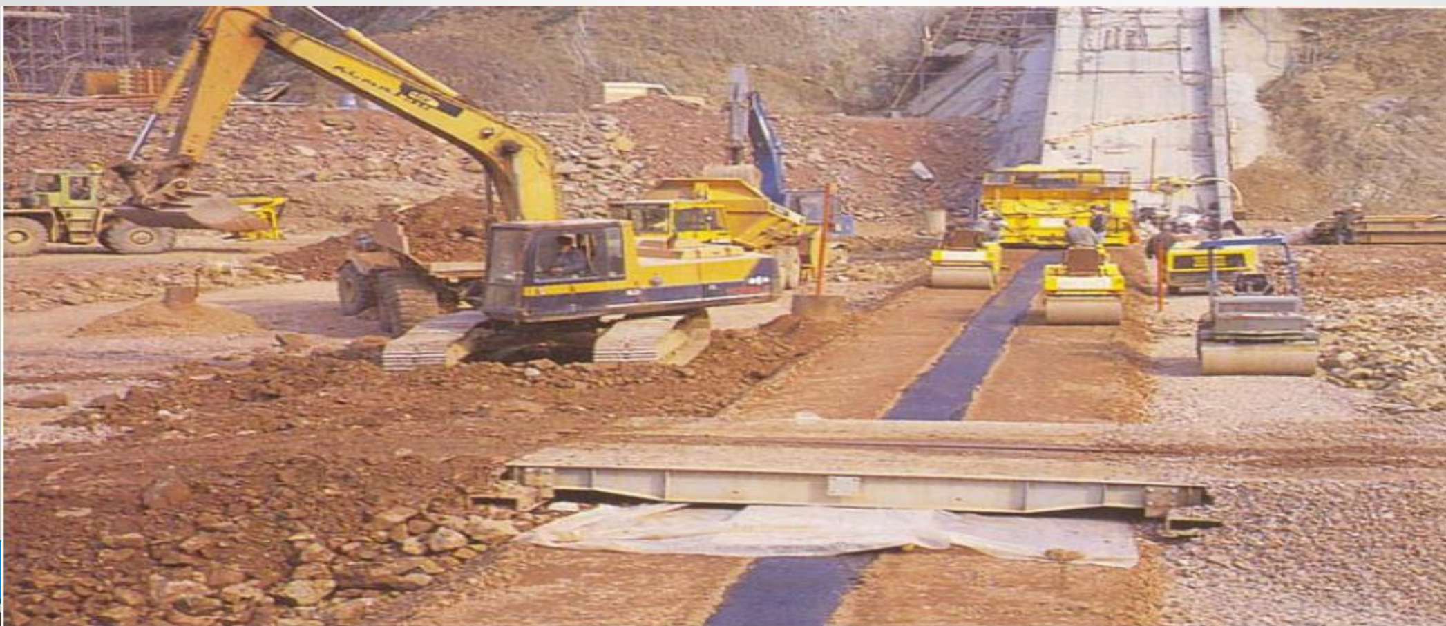
شکل ۸- پل فولادی سبک بر روی هسته
