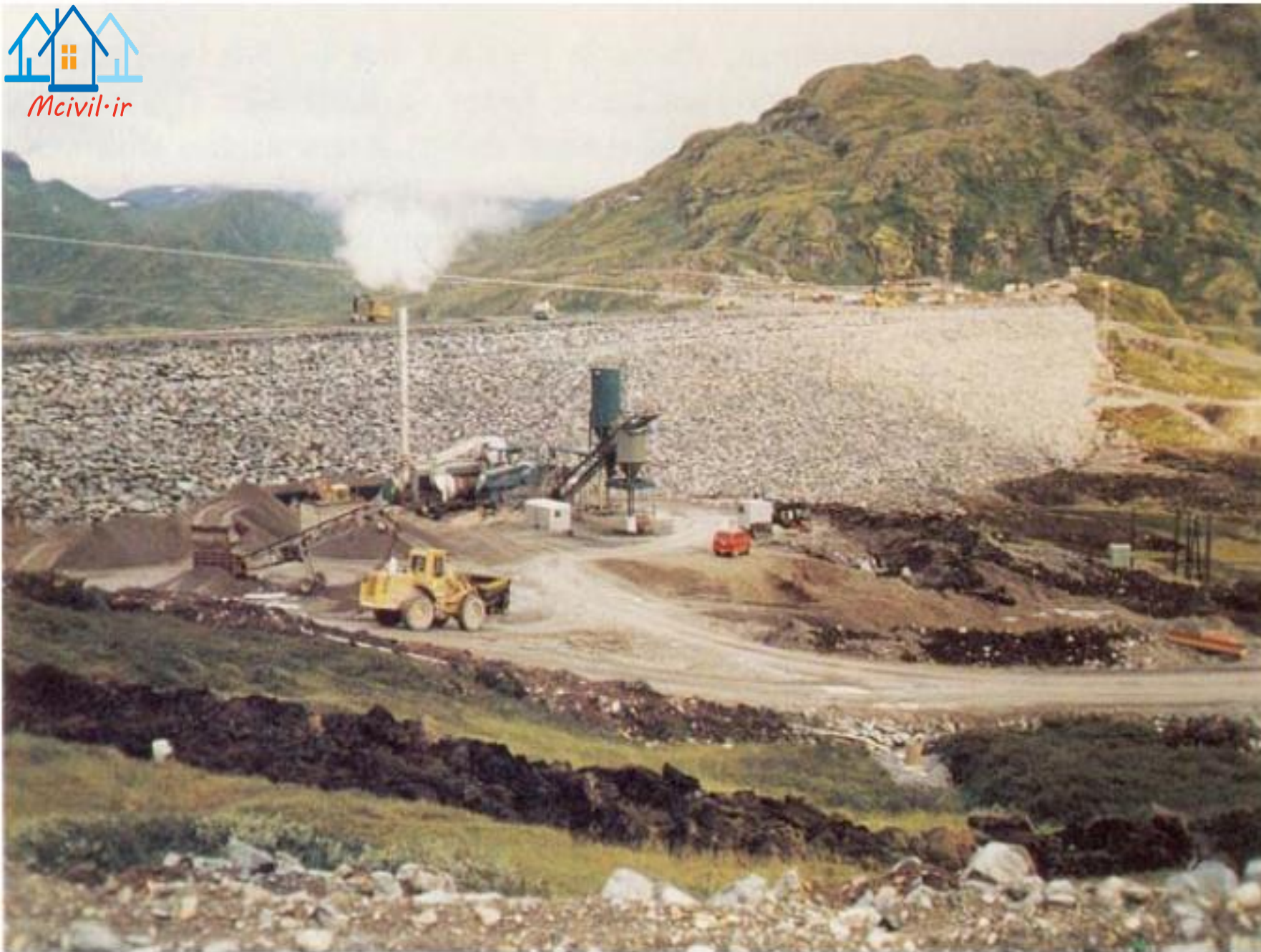
شکل ۲- بچینگ پلنت در نزدیکی پایاب سد
