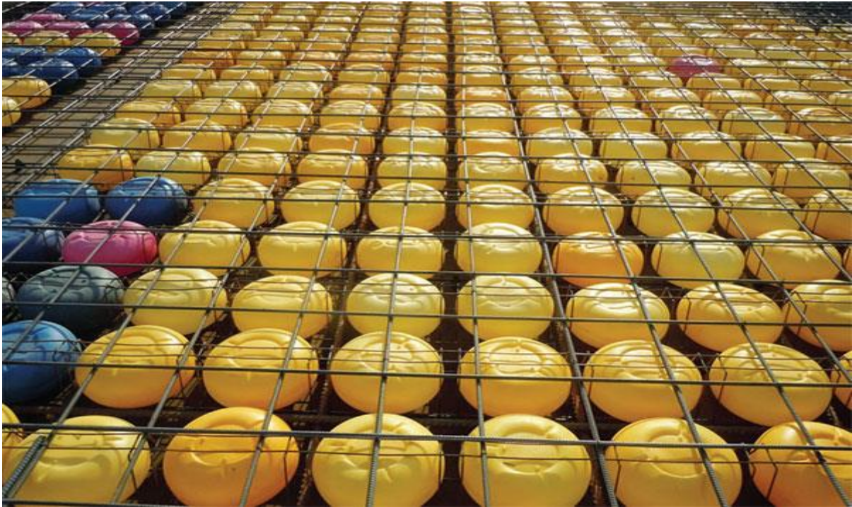
۴. اجرای شبکه آرماتور بالایی
