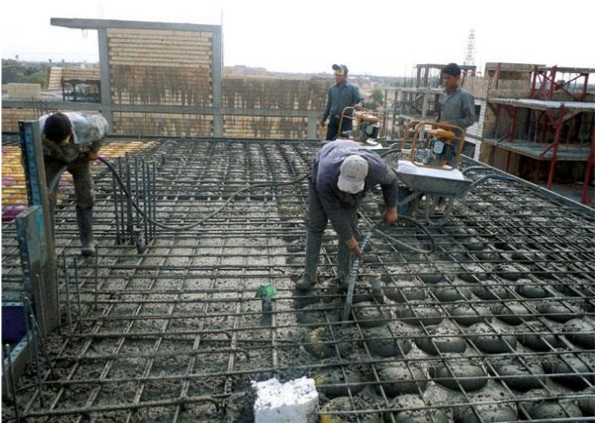
۵. بتن ریزی و ویبره زدن
