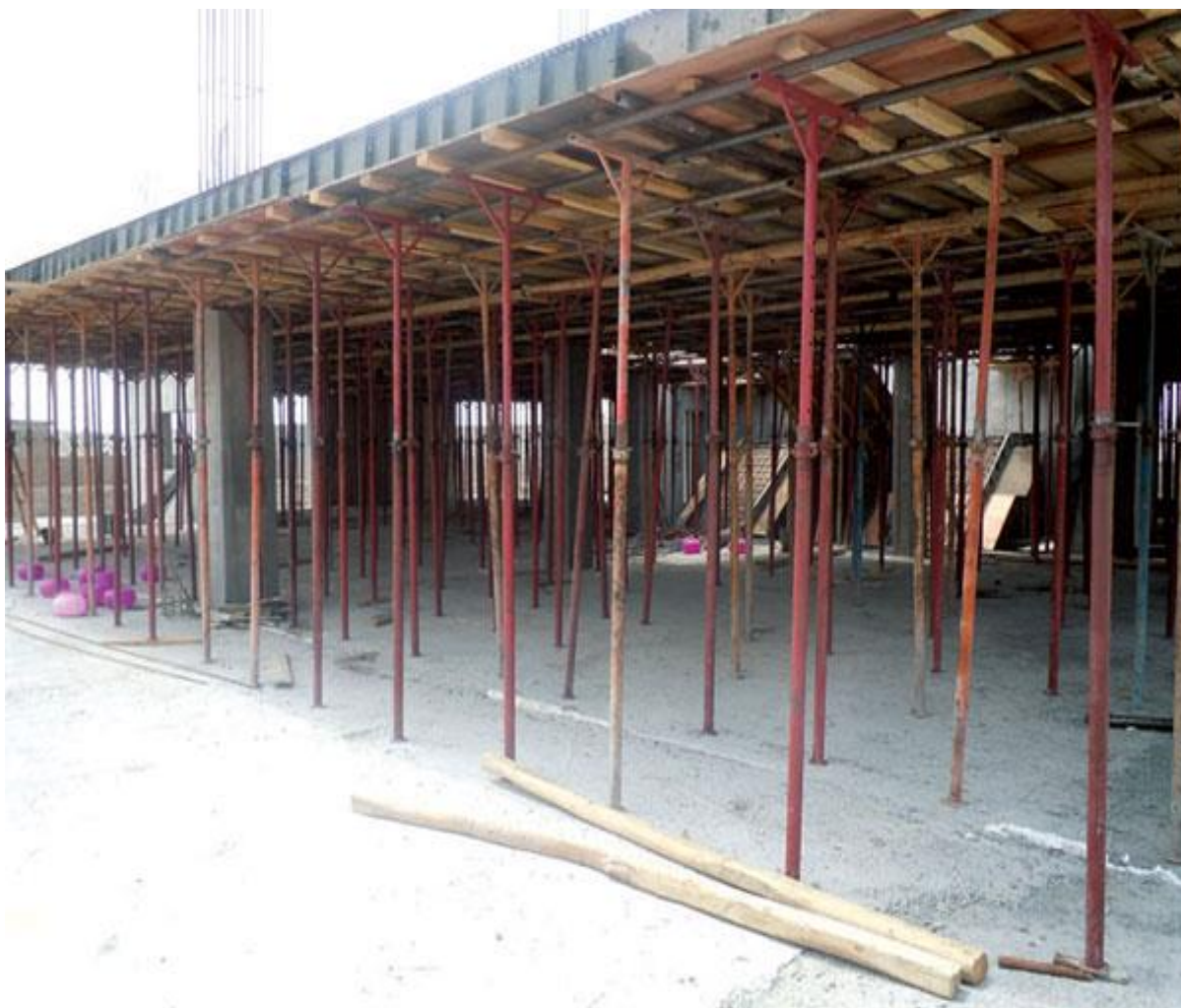
۱. قالب بندی سقف
