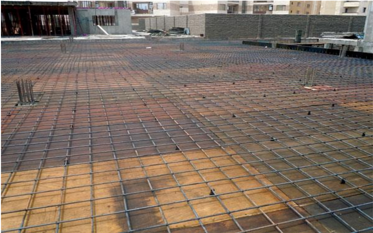
۲. اجرای شبکه آرماتور پایینی
