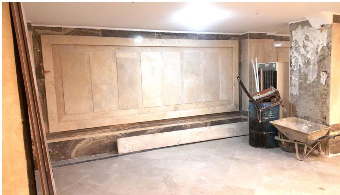
شکل ۳- عدم سنجکاری ستون برای تامین پارکینگ، به علت عدم دقت در جانمایی ستون ها.
