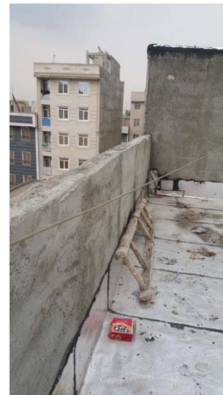
شکل ۲۱ - عدم اجرای دربوش جانبیه بام و عدم اجرای قرنیز کف پنجره
