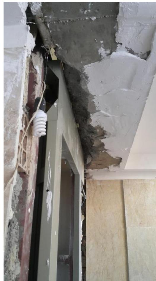
شکل ۱- تخریب پوتو برای نصب درب آسانسور به علت عدم دقت در جانمایی و کنترل ابعاد چاله آسانسور
