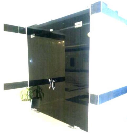
شکل ۱۹ - عدم اجرای درب دودبند و مقاوم حریق
