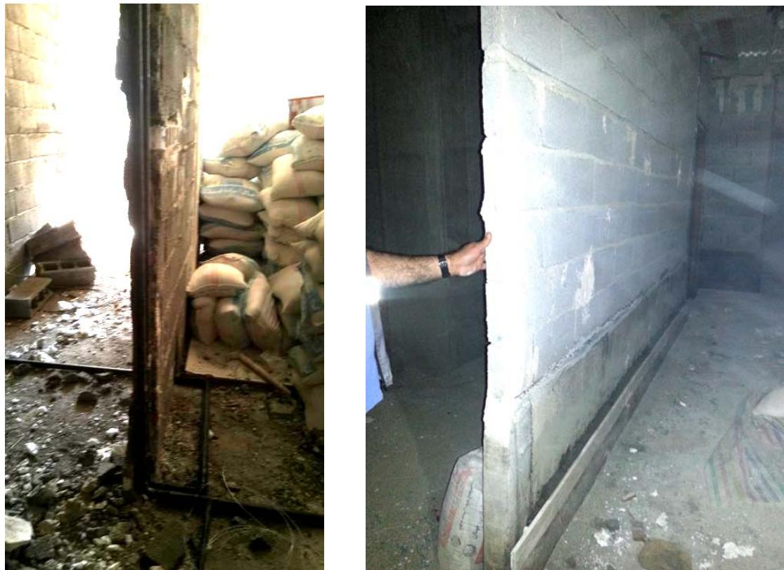
شکل ۶ - عدم رعایت ضخامت دیوارهای خارجی و مجاور فضای کنترل نشده مغایرت با مبحث ۱۹
