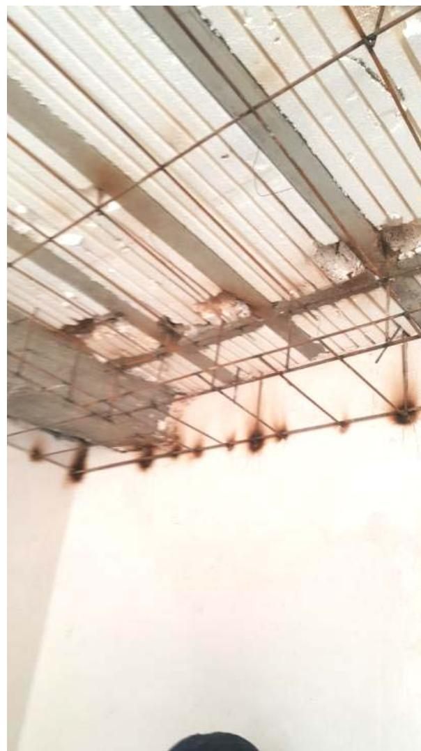
شکل ۱۸- ساپورت گیری نامناسب از تیرچه و تخریب آنها
