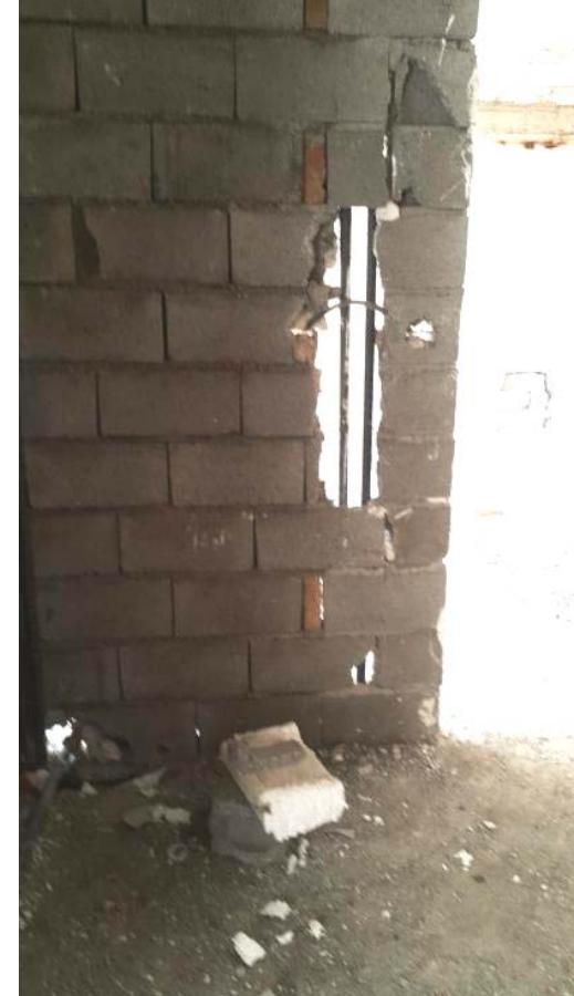
شکل ۱۱ - تخریب دیوارها جهت عبور لوله های تاسیساتی
