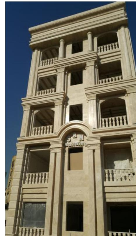
شکل ۱۵ - نمای پروژه با احجام و پیش آمدگی بیش از حد مجاز و استفاده از صراحی و ایمن نبودن نرده سنگی(صرابی) نما از لحاظ ارتفاع و اتصال به سازه اصلی
