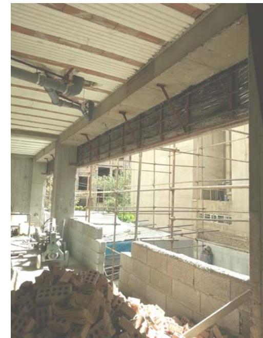
شکل ۸- اجرای نبشی کشی جهت اجرای سازه نگهدارنده نما و عدم توجه به آن در مرحله اسکلت و سقف که موجب تخریب پوتر شده است
