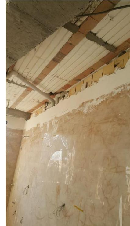
شکل ۷- عدم هشتگ مناسب تیغه به سقف و عدم گیری و اتصال صحیح بین دو دیوار
