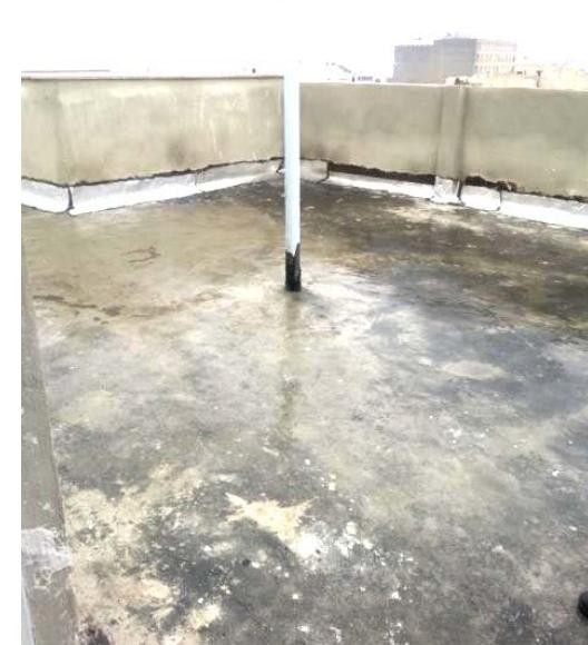
شکل ۱۲ - عدم استفاده از دربوش برای جانپناه شرقی و غربی و عدم دیوار کشی و محافظت اطراف لوله های ونت
