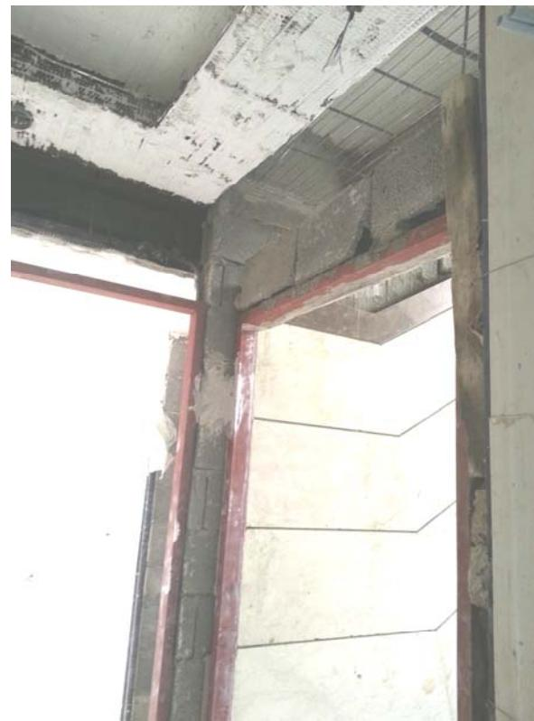
شکل ۱۰ - عدم اجرای نعل درگاه یا کمرکش برای درب های داخلی ساختمان
