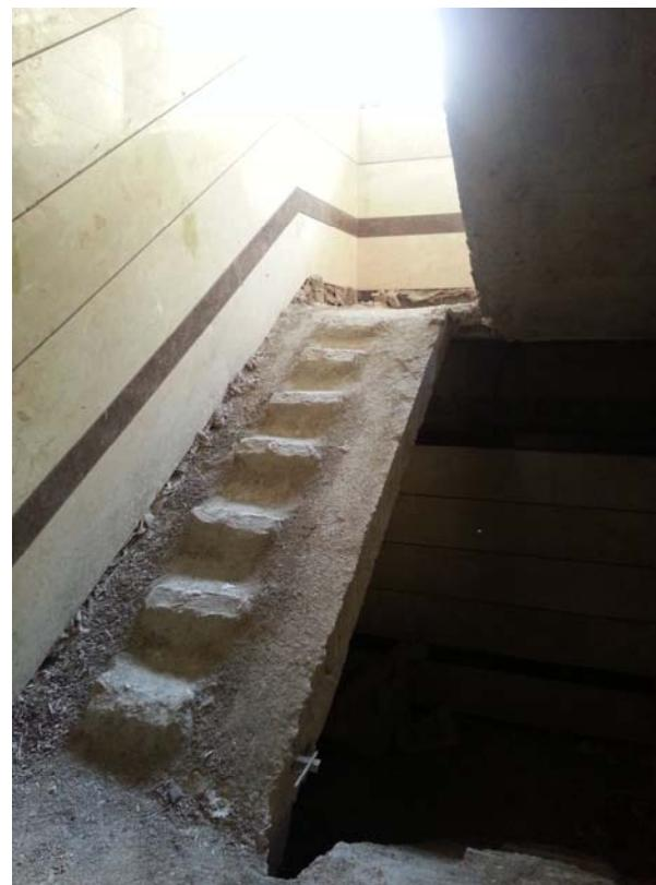
شکل ۲- افزایش ارتفاع طبقه باعث افزایش شب شمشیری شده و به تبع آن تعداد و ارتفاع تک پله در نازک کاری افزایش می یابد.
