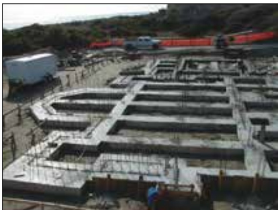
شکل ۳-۶۲ پی بتن مسلح نواری شبکه ای زیرستون
