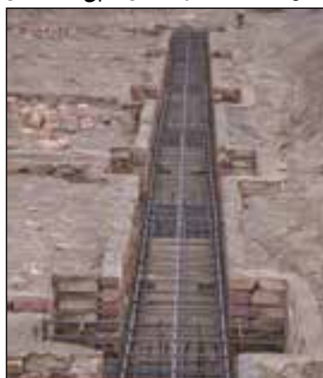
شکل ۳-۱۳۶ پی و شناژ قبل از بتن ریزی
