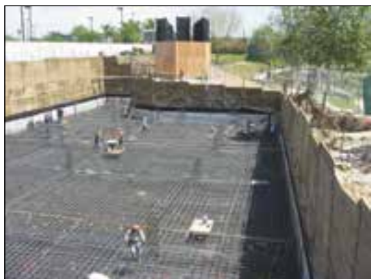
شکل ۳-۶۸ پی بتن مسلح یکپارچه (رادیه ژنرال)
