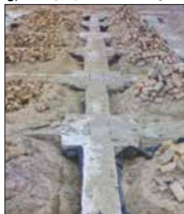
شکل ۳-۱۳۷ پی و شناژ بعد از بتن ریزی
