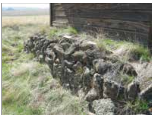
شکل ۳-۴۰ پی سنگی با سنگ لاشه
