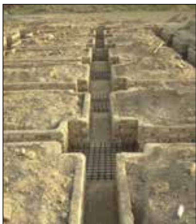
شکل ۳-۵۴ آرماتورگذاری پی تکی کلاف بندی شده
