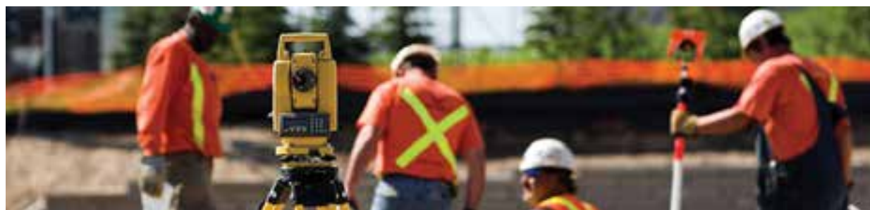
شکل ۴-۱. پیاده کردن با دوربین نقشه‌برداری
