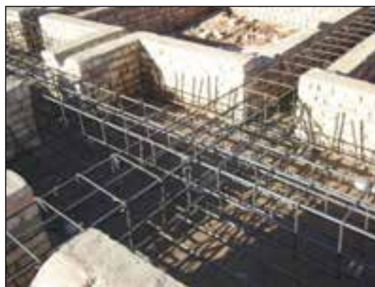
شکل ۳-۱۳۵ عبور میلگردهای شناژ در پی
