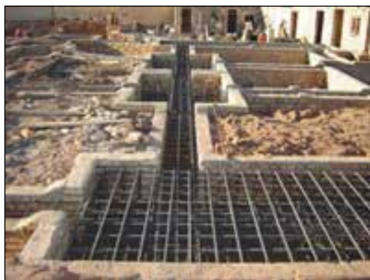
شکل ۳-۱۳۴ میلگردگذاری در پی کلاف بندی
