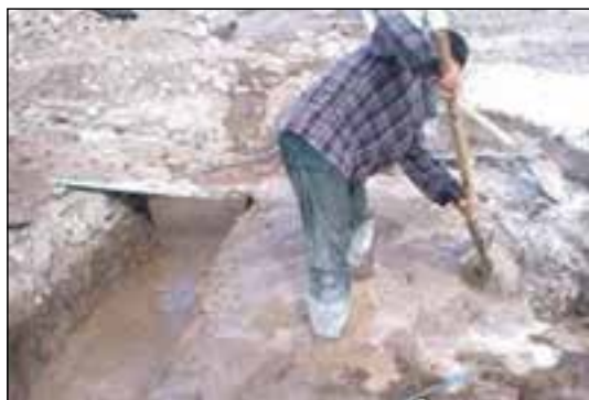
شکل ۳-۳۷ اجرای شفته آهک در فونداسیون
