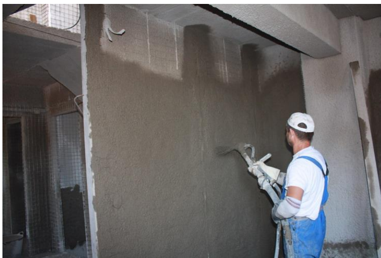
اجرای شاتکریت در دیوار بتنی
