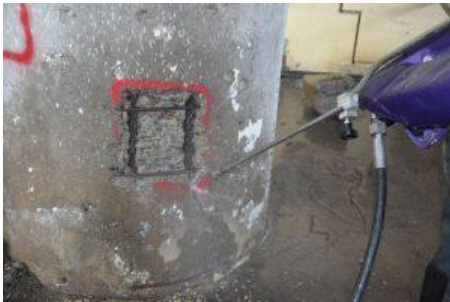
تخریب بتن کرمو با واتر جت صنعتی
