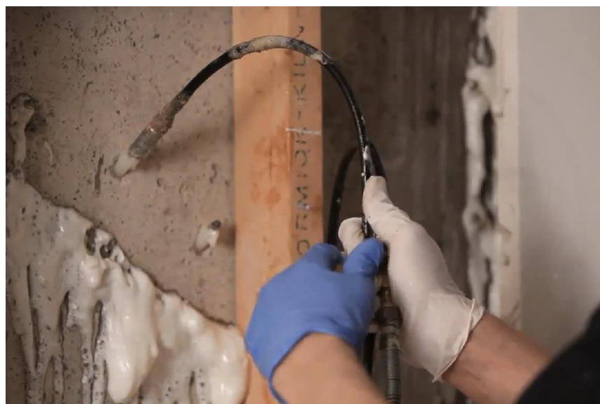
تیر بتنی ترک خورده با ملات اپوکسی
