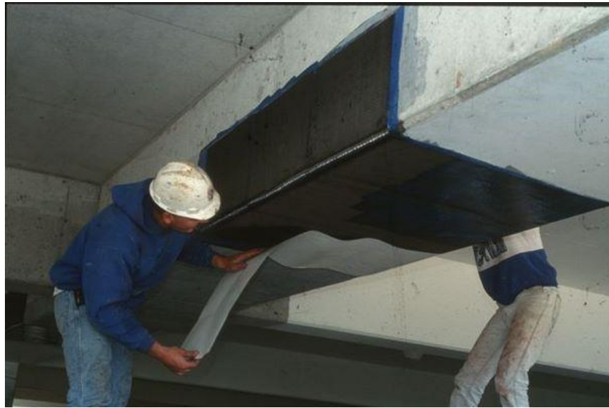
ترمیم تیر بتنی کرمو شده با استفاده از FRP
