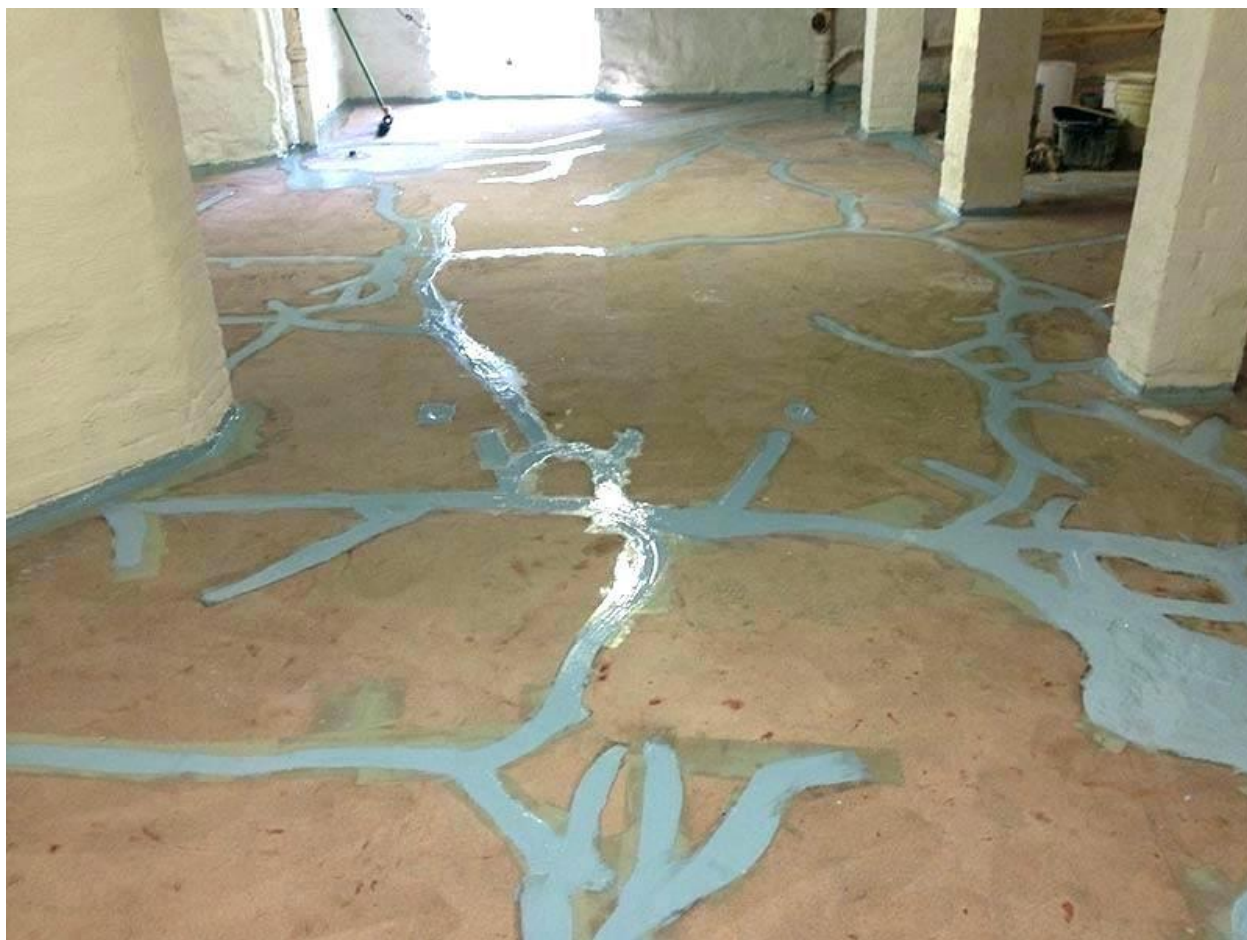
ترمیم ترک در بتن با اپوکسی
