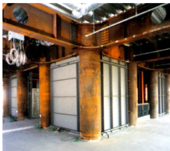
شکل 1-8: دیوارهای برشی فولادی سخت نشده
