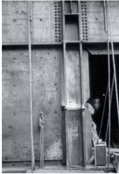
شکل 1-19- توسعه بیمارستان H.C.Moffit، جزئیات تیپ دیوارهای برشی فولادی و نمونه‌ای از سطح مقطع (Dean و همکاران، 1977؛ Wosser و Poland، 2003)
