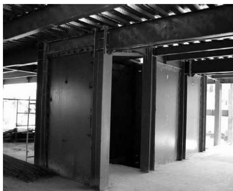
شکل 1-6: دیوارهای برشی فولادی سخت نشده
