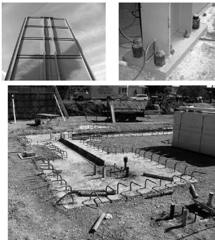
شکل 1-32- دیوار برشی فولادی و جزئیات پای دیوار، ساختمان ING
