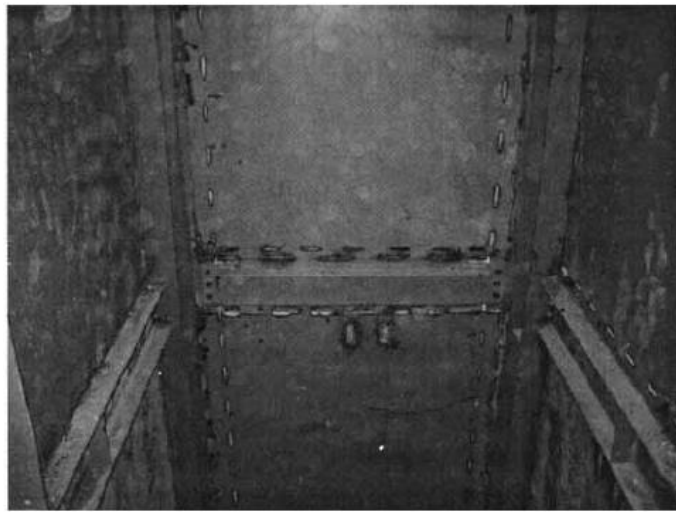
شکل 1-35- ساختمان دارای دیوار برشی فولادی در مکزیك-نمای داخلی دیوارها در اطراف هسته آسانسور
