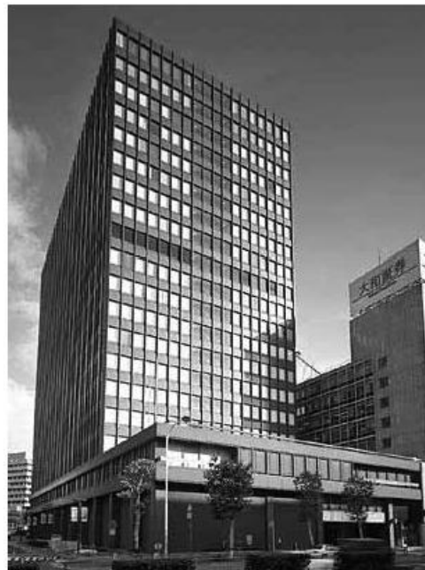
شکل 1-11- ساختمان Nippon Steel (سمت راست)
