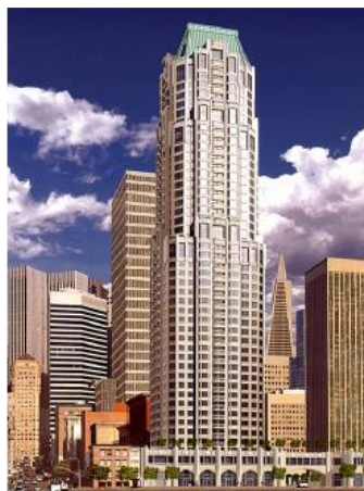
شکل 1-37: ساختمان مسکونی ۵۱ طبقه واقع در سان فرانسیسکو
