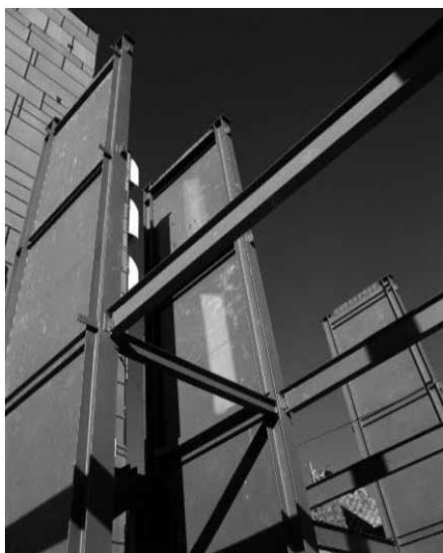
شکل 1-29- دیوار برشی فولادی در توسعه ساختمان مرکزی Canam Manac Group
