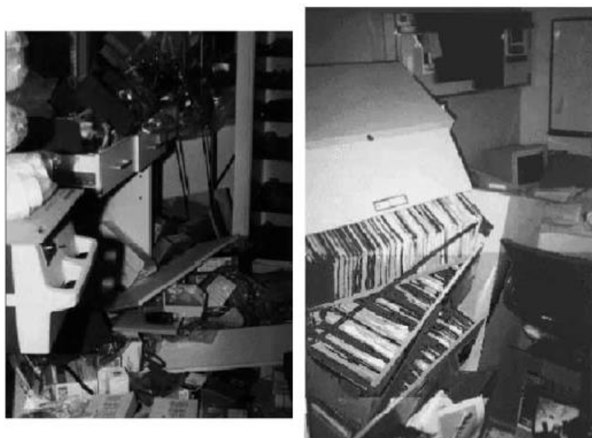
شکل 1-24- خسارت غیرسازه‌ای در بیمارستان Olive View در زلزله 1994 نورث ریج (Naeim)
