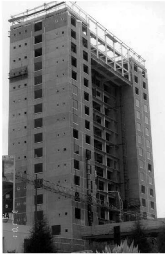
شکل 1-36- ساختمان دارای دیوار برشی فولادی در مکزیک (مارتینز-رومئو 2003)
