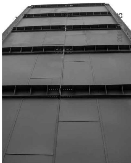
شکل 1-31- نمای نزدیک دیوار در محل وصله وسط دهانه، ساختمان ING
