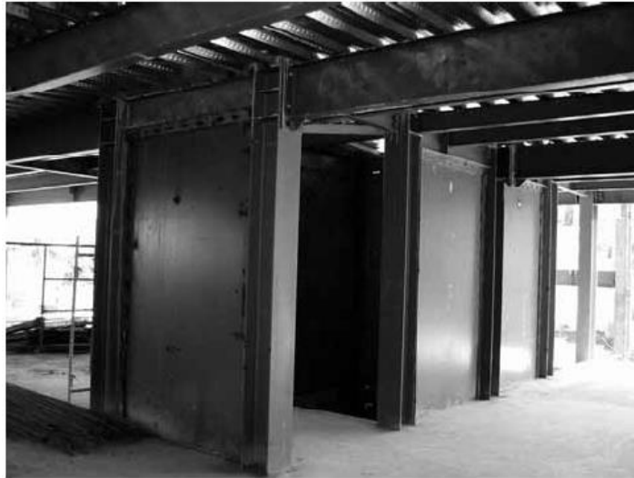
شکل 1-34- ساختمان دارای دیوار برشی فولادی در مکزیك-نمای خارجی دیوارها در اطراف هسته
