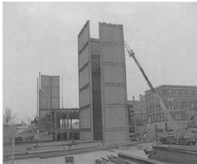
شکل 1-30- هسته دیوار در وسط ساختمان ING
